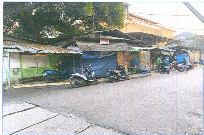
Lampiran 1 - Kondisi akses Jalan Padang melalui persimpangan Jalan Padang Panjang
