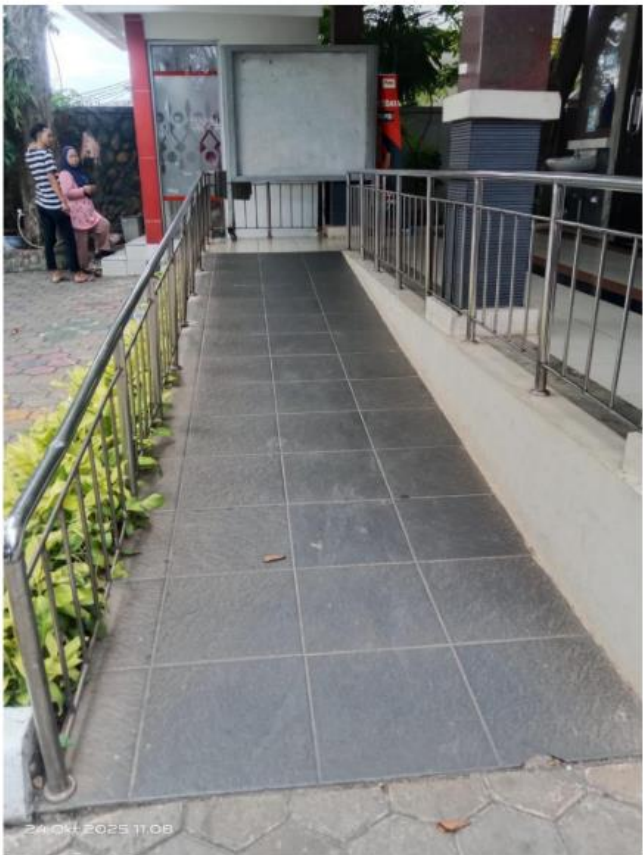
Step lobby/ramp/jalan landai dengan pegangan rambat
