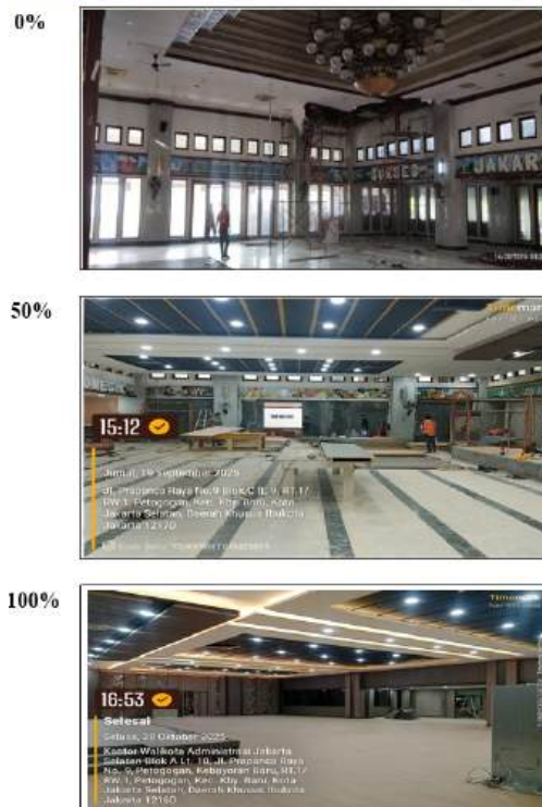
Gambar 3. 2 Dokumentasi Renovasi Kantor Walikota Jakarta Selatan
